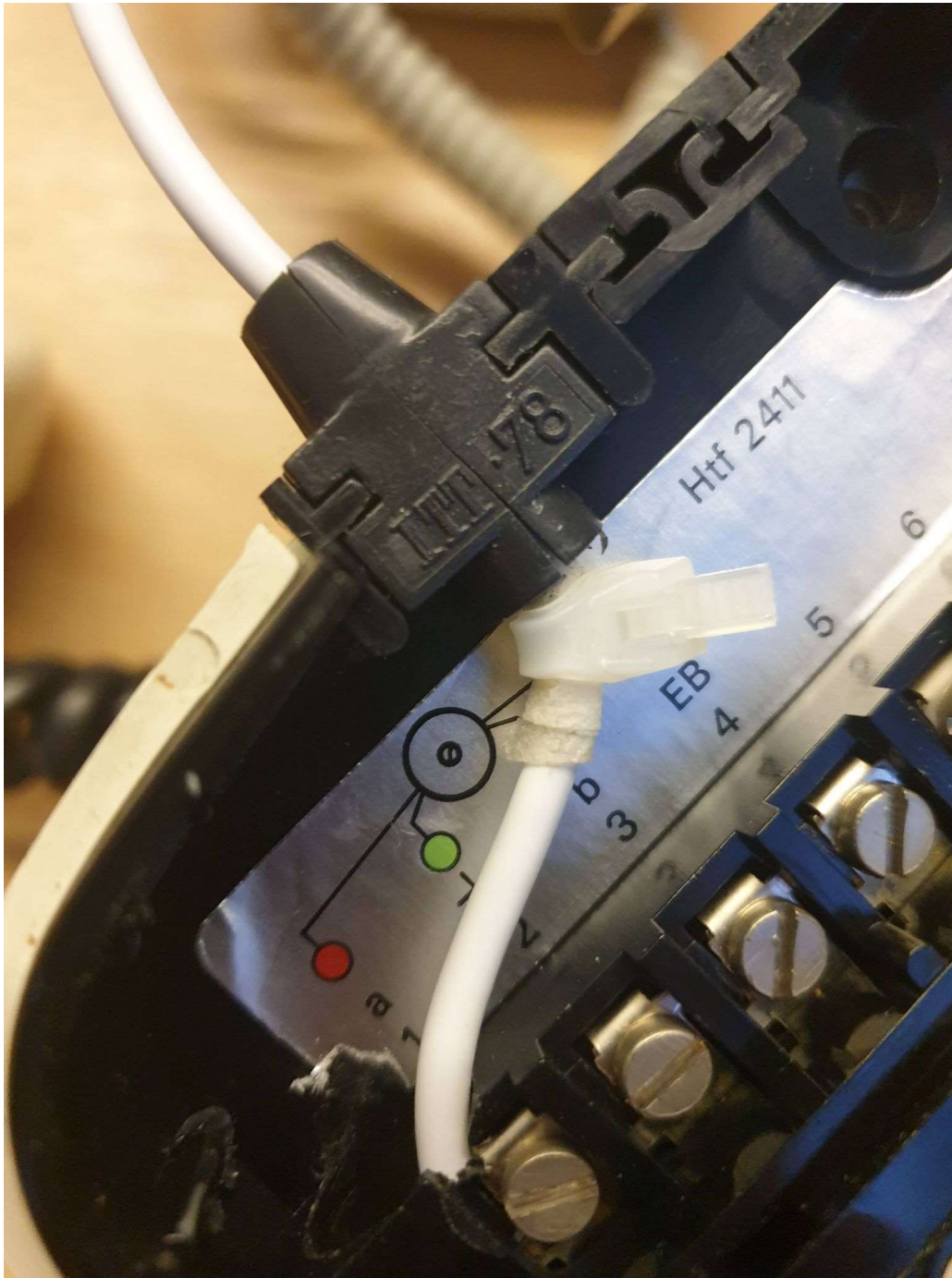
(voorbeeld in het zwart) Zo ziet het er dan uit. Ook is er een trekontlasting gemaakt met een tie-wrap.
